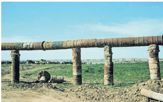
Improvisierte Wasserleitung aus Blechtonnen, Irak 1976.
