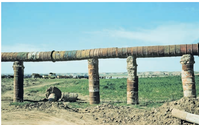
Improvisierte Wasserleitung aus Blechtonnen, Irak 1976.
